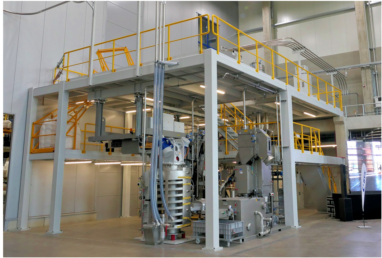
Durch die neue Extrusionsanlage erhöht sich die Produktionskapazität der Firma Byk um ein Viertel. In der Halle ist Platz für drei weitere Anlagen.
