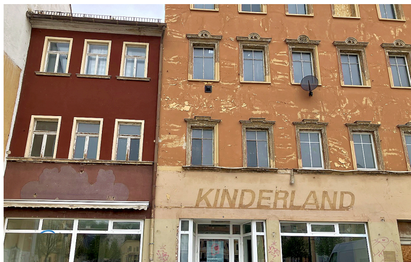
Die Firma Metron plant die Sanierung des ehemaligen Spielwarengeschäfts „Kinderland“ am Weißenfelser Markt. FOTO: ANDREAS RICHTER
