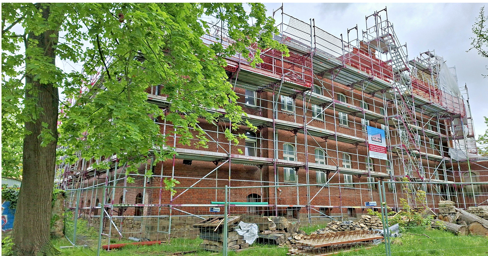
Einst Amtsgericht, später Gymnasium, landläufig „E-Gebäude“ – der markante Backsteinbau an der Pestalozzistraße in Lützen wird derzeit als Erweiterungsbau für die Grundschule saniert. Im Rahmen des Tags der Städtebauförderung informiert ein Programmpunkt über den Baufortschritt.
