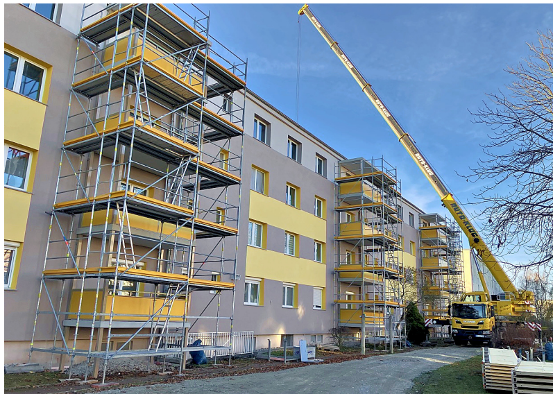
Der Röntgenweg 14 bis 20 erhält derzeit neue Balkone.
